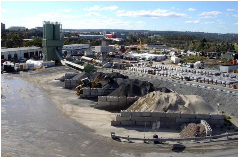
Bild 5: Blick über die Projektbaustelle „M2“ mit Betonmischanlage, Bürocontainern, Werkstätten und Materiallagerflächen
