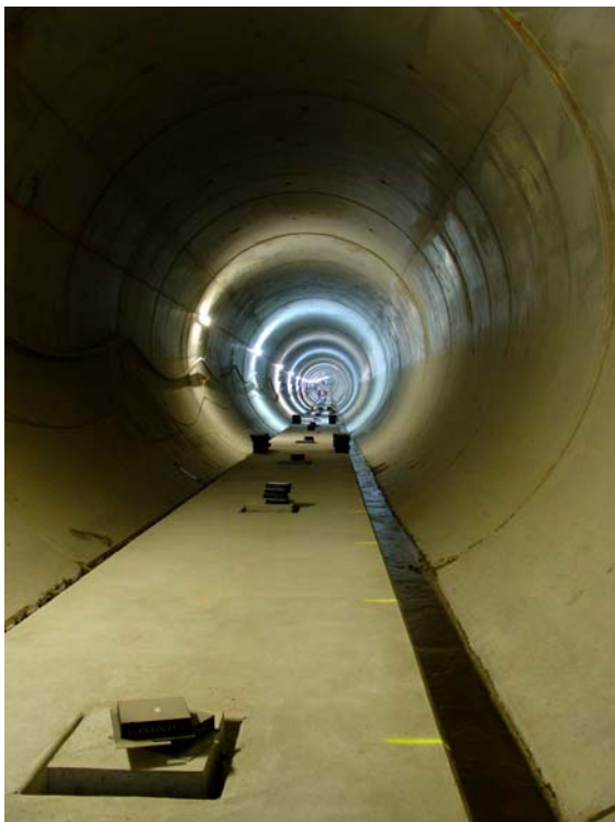
Bild 4: Fahrbahnplatte vom Typ FST vor dem Anheben; deutlich erkennbar die Schubkraftwürfel entlang der Längsachse sowie die noch nicht platzierten Dämpferelemente
