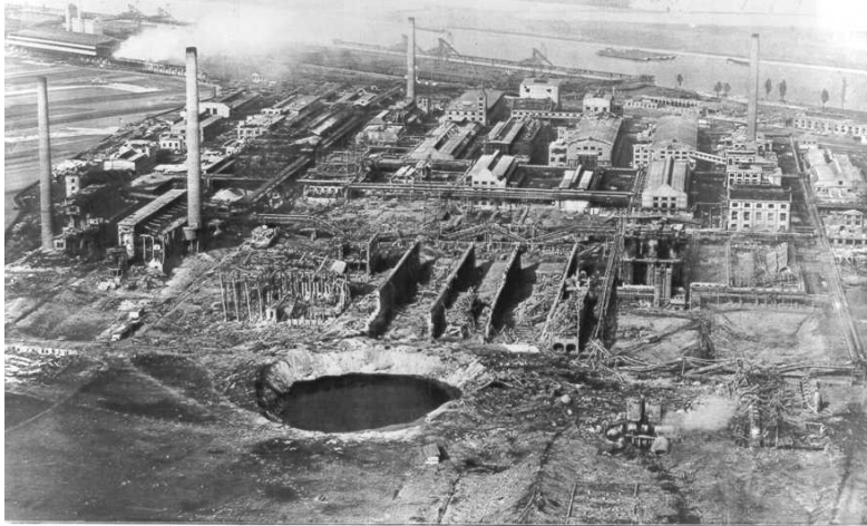
VUE AERIEUNE DE L'USINE DE LA « BADISCHE ANILIN UND SODA FABRIK », A OPPAU, APRES LA FORMIDABLE EXPLOSION DU 21 SEPTEMBRE. Au premier plan, le cratère formé par la mystérieuse déflagration et à demi rempli d'eau par les canalisations rompues et par les infiltrations souterraines; au delà, les bâtiments restés ou défilés; à l'arrière-plan, le Rhin. Photographie prise d'un avion spécialement équipé au printemps 1922 par L'ingénieur, par le Comte, Adrien Prévost. — Tous droits réservés.
